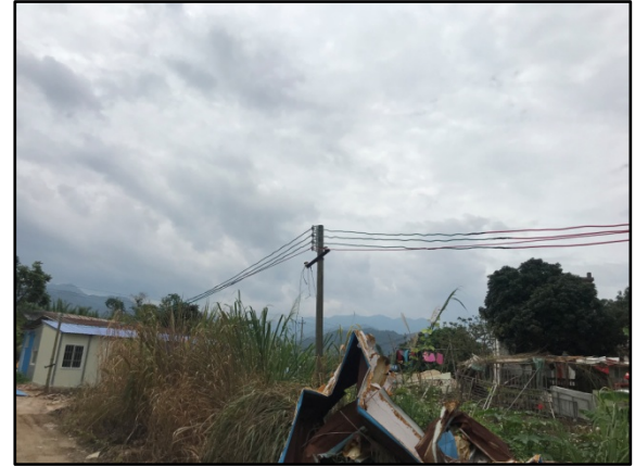
项目西面铁皮房
