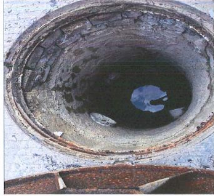
生活污水排放口
