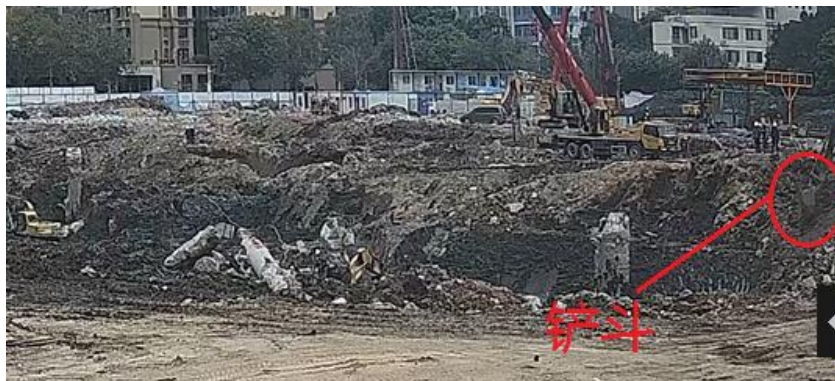
(图3 事发降坡卸土作业的开挖方式)
